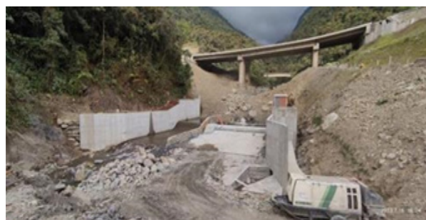
Obras civiles en el túnel secundario del proyecto Central Hidroeléctrica San José
